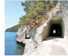
明治時代に掘られた2つのトンネルが並んでいます。海側の小さなトンネルは手掘りのトンネル、陸側の大きいトンネルは手掘りしと爆薬を使って掘られた後、昭和時代に重機で拡張されました。これらのトンネルは「徒歩」→「馬車」→「自動車」へと移り変わった人の営みと土木技術の推移を反映したものであることから日本土木学会が定める土木遺産に選定されています。また湾内にある福浦岸壁はローソク島遊覧船の発着港となっています。ローソク島は隠岐の自然が創り出した巨大なローソク状のオブジェで、海上に浮かぶローソク島に火が灯る瞬間の光景は、いつまでも訪れる人の記憶に残ります。
