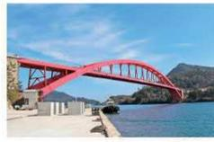
赤色が映える西郷大橋は、港町のシンボリックな存在で、隠岐世界ジオパーク空港への連絡道としても利用されています。昭和54年の建築当時は日本最大のローゼ橋でした。
